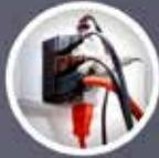
Branchez les appareils dans plusieurs prises pour éviter de surcharger un circuit électrique. Utilisez une barre d'alimentation dotée d'un dispositif anti-surcharge.
